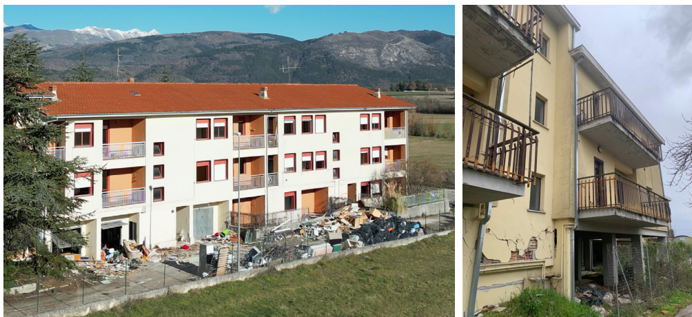
Fig. 2. a sinistra, edificio ATER L'Aquila danneggiato dal sisma del 2009 sito a Preturo (AQ).
